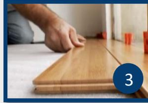
Unión de las tablas mediante sistema unilin cick.
